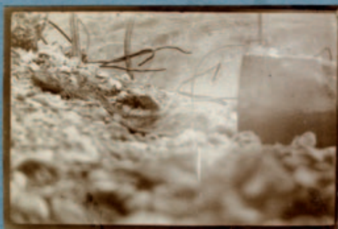
Superstructure du fort Photo prise hâtivement en passant le bras, entre deux pilonnages, par la trouille démantelée du 75, l'autre restant rampante à l'un des bords de l'échelle de fer.
